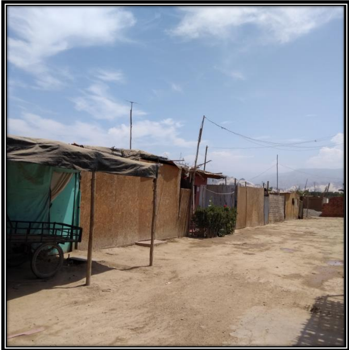
Centro Poblado las Torres del Mantaro expuestas a lluvias intensas
