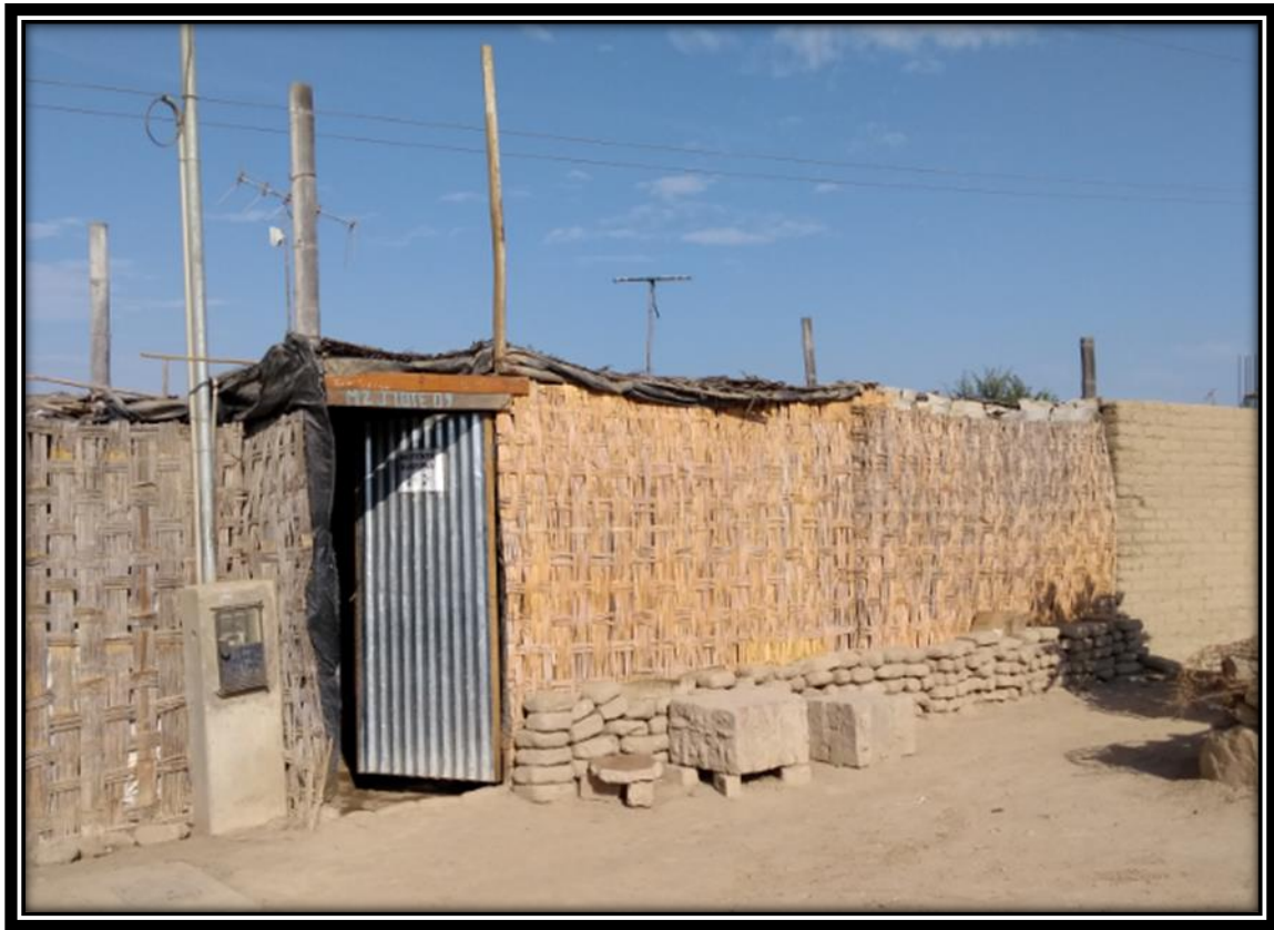
Centro poblado 9 de Diciembre, material predominante esteras, plásticos expuestos a lluvias intensas.
