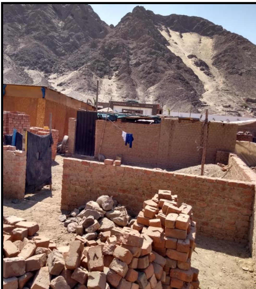
Viviendas de adobe, ladrillo sin columnas en la parte baja de quebrada cruces
