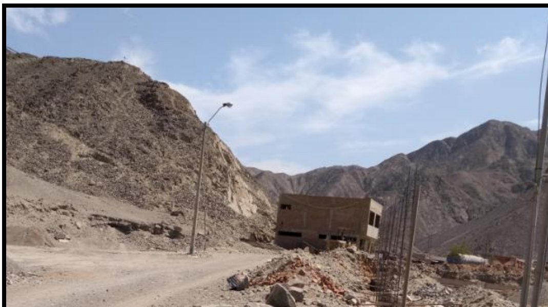
Viviendas construidas por autoconstrucción en la parte baja de las quebrada cruces
