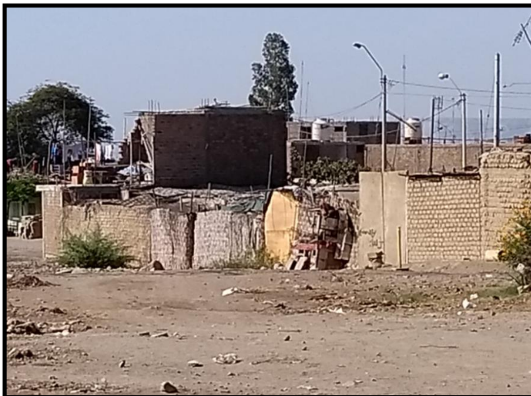
Viviendas de adobe en el Centro de poblado las torres del Mantaro.
