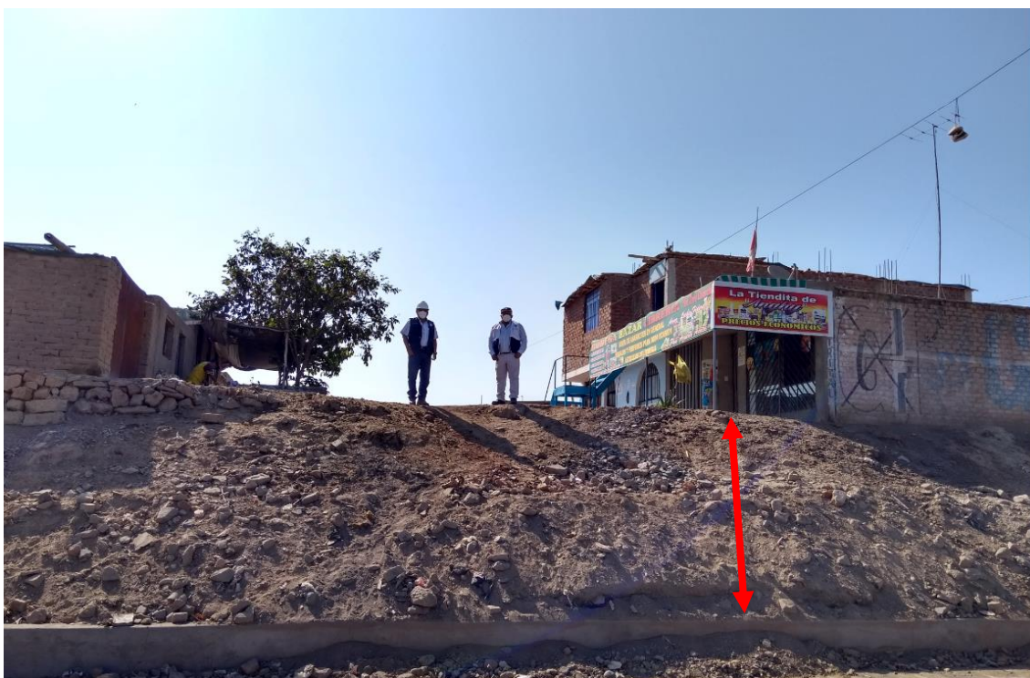
Viviendas ubicadas sobre relleno sanitario Centro Poblado los peregrinos
