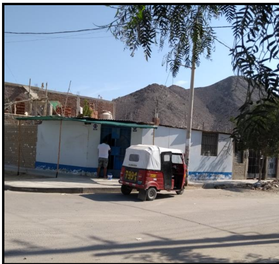
Viviendas expuestas a caídas de rocas a consecuencia de Sismo
